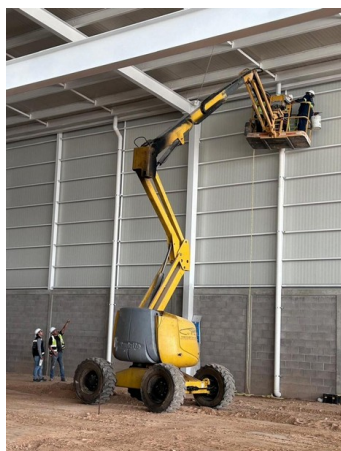
Montaje en altura con plataforma articulada
