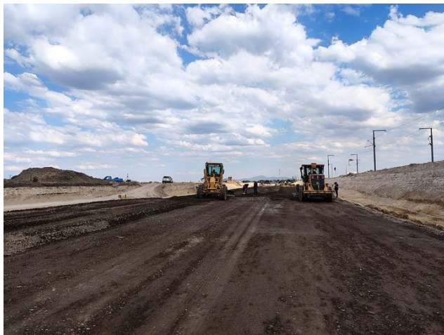
Operación simultánea de motoconformadoras en plataforma
