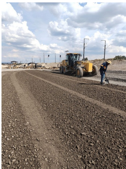
Extendido de capa con motoconformadora
