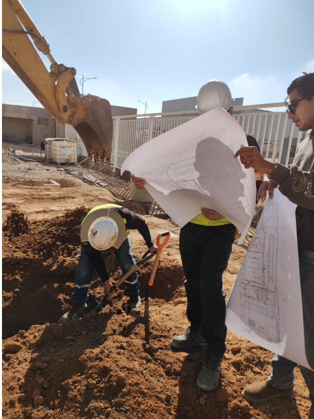
Verificación de trazo y niveles en zanja, contra ingeniería en sitio
