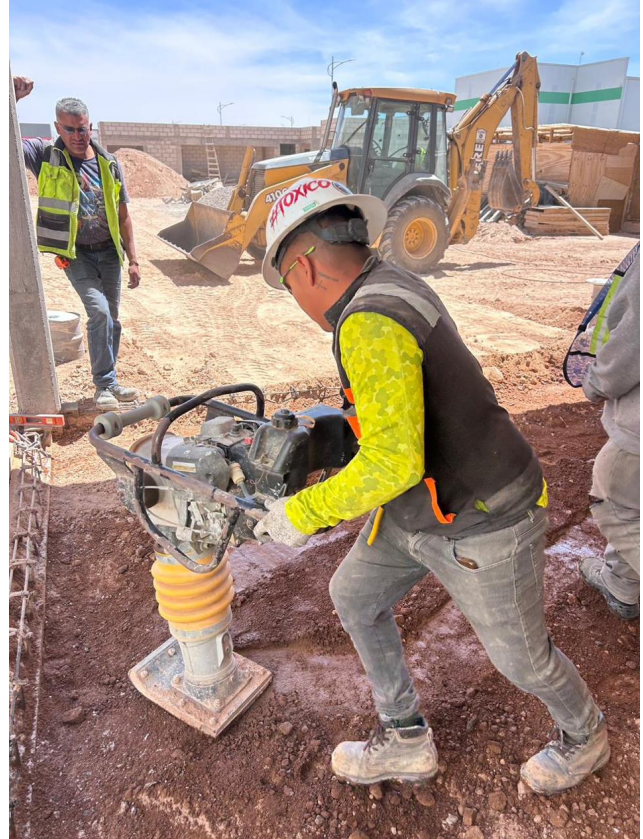
Compactación controlada de relleno de zanja con equipo propio
