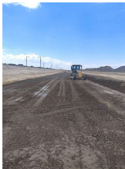
Conformación de plataforma bajo catenaria
