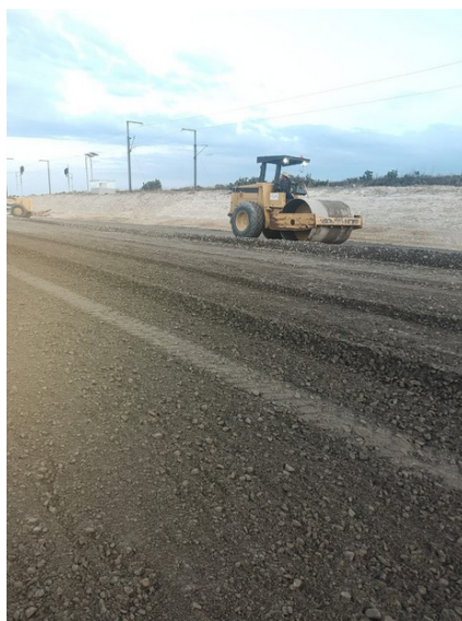
Compactación con rodillo vibratorio liso
