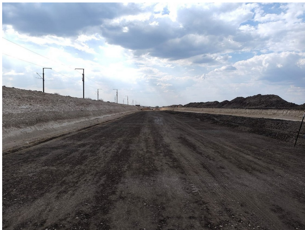
Tramo con taludes conformados y plataforma nivelada
