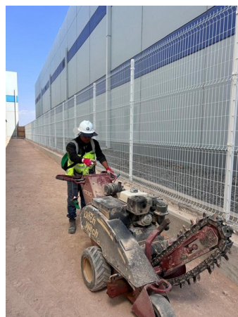
Corte y apertura de zanja con equipo especializado
