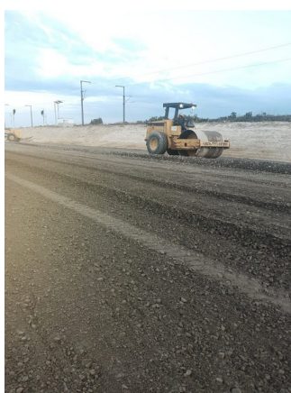
Vibrocompactador en compactación de terraplén
