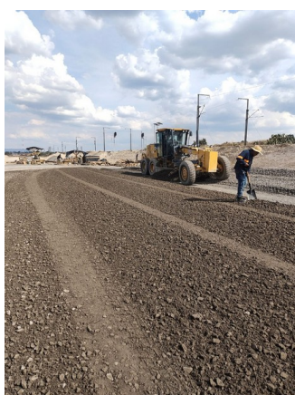
Motoconformadora en extendido de capa
