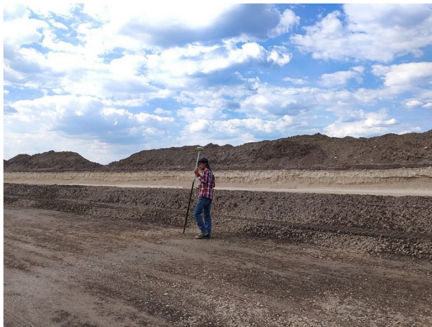
Control topográfico con equipo GPS
