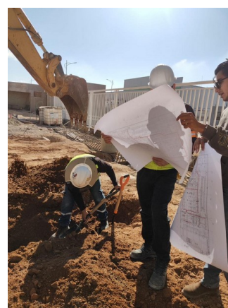
Excavadora y personal con EPP completo
